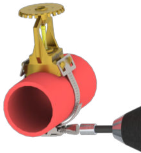
Figure 5 : Serrer le collier à l'aide d'une visseuse
